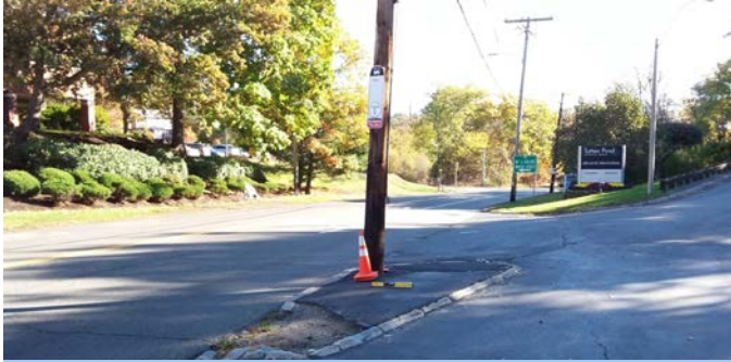
400 Totten Pond Rd., Waltham
