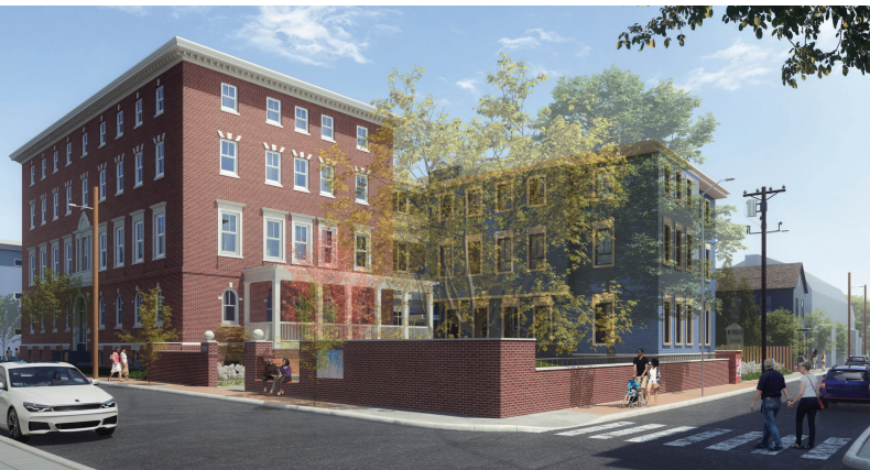
116 Norfolk Street. 62 套经济适用租赁单元正在施工中，并为低收入居民提供现场支持服务。
