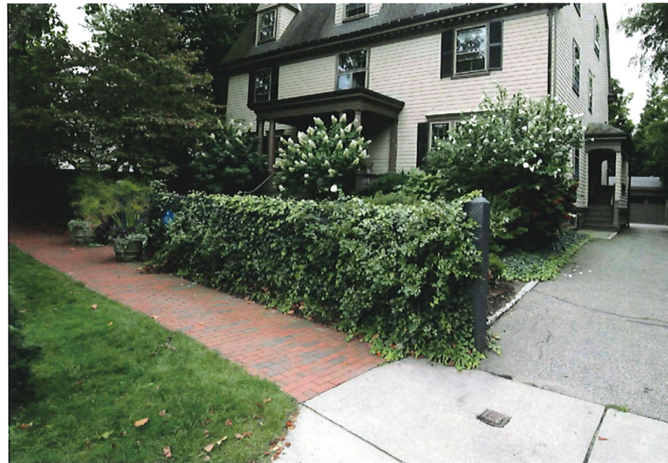
2 EXISTING SITE CONDITIONS SCALE: N.T.S. IMAGE
