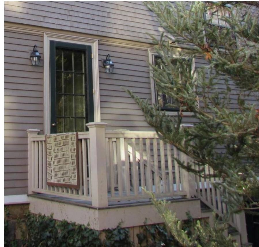
EXISTING DOOR #5 TO BE REUSED
