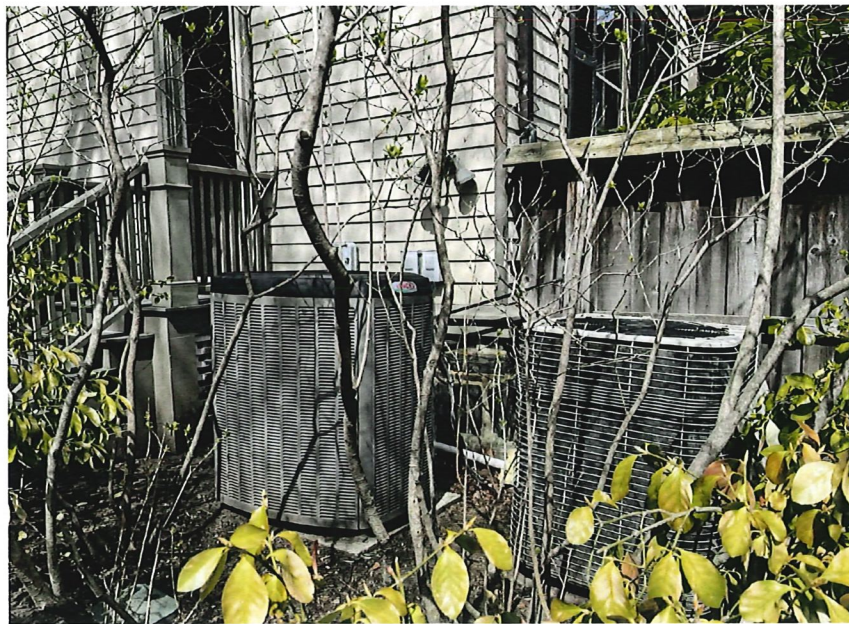
2 EXISTING SITE CONDITIONS SCALE: N.T.S. IMAGE
