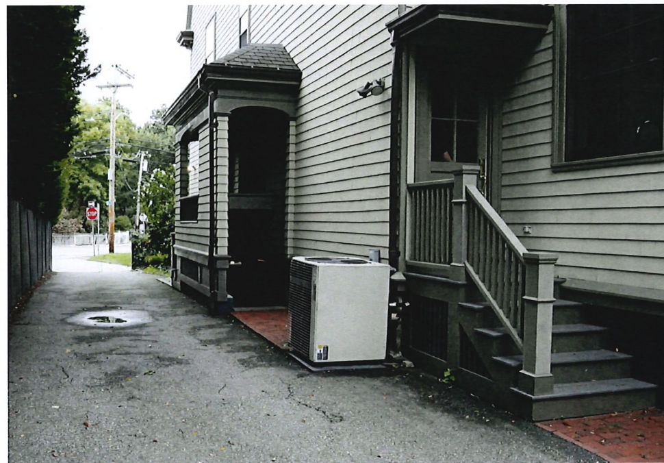
4 EXISTING SITE CONDITIONS SCALE: N.T.S. IMAGE
