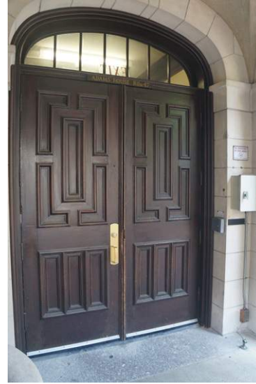
EXISTING B-ENTRY DOOR
