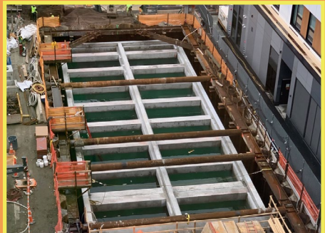
第一阶段建设的停车场 6 号储水池。
