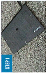
INSTALL FLASHKIT PRO FLASHING
