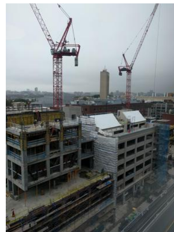
MIT development under construction in Kendall Square
